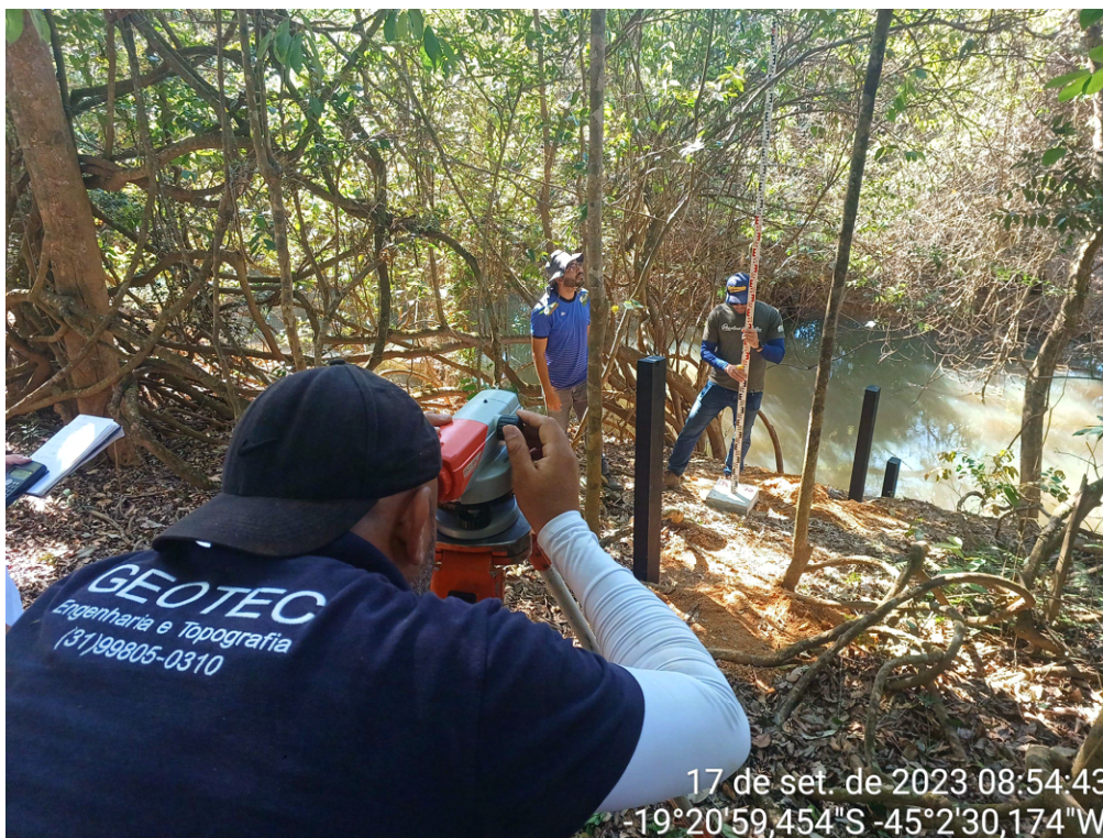
Figura 3.10 – Transferência de cota altimétrica RN-03 (“Visada de vante”). Fonte: GAMA ENGENHARIA (2023).
