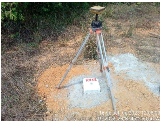
Figura 3.7 – Rastreamento de posição por GPS. Fonte: GAMA ENGENHARIA (2023).
