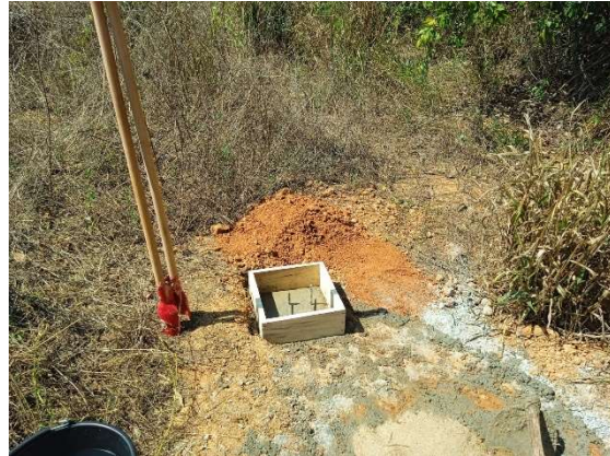
Figura 3.6 – Registro do processo de materialização do RN-01. Fonte: GAMA ENGENHARIA (2023).
