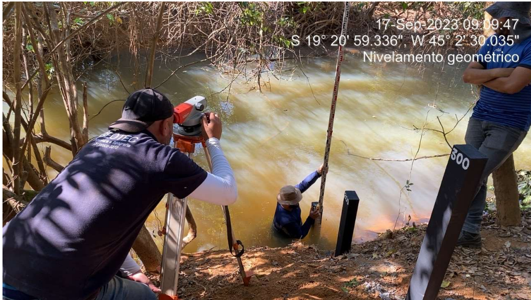
Figura 3.13 – “Visada de ré” para assentamento da segunda régua, mourões já posicionados, concretados e alinhados verticalmente. Fonte: GAMA ENGENHARIA (2023).
