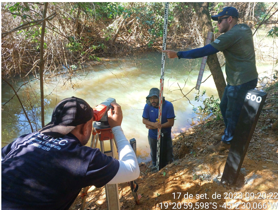
Figura 3.14 – “Visada de vante” para assentamento da segunda régua, mourões já posicionados, concretados e alinhados verticalmente. Fonte: GAMA ENGENHARIA (2023).
