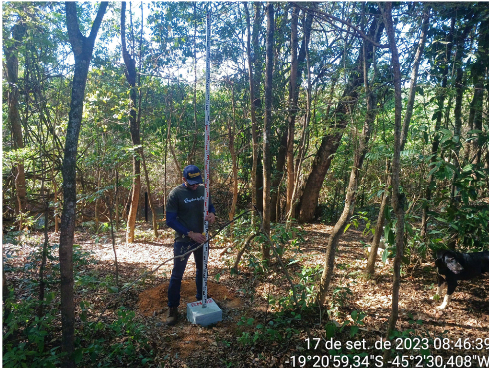
Figura 3.9 – Transferência de cota altimétrica RN-02 (“Visada de ré”). Fonte: GAMA ENGENHARIA (2023).
