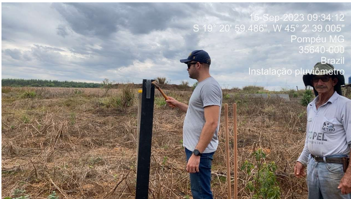
Figura 4.2 – Morador da propriedade acompanhando o processo de instalação do pluviômetro. Fonte: GAMA ENGENHARIA (2023).
