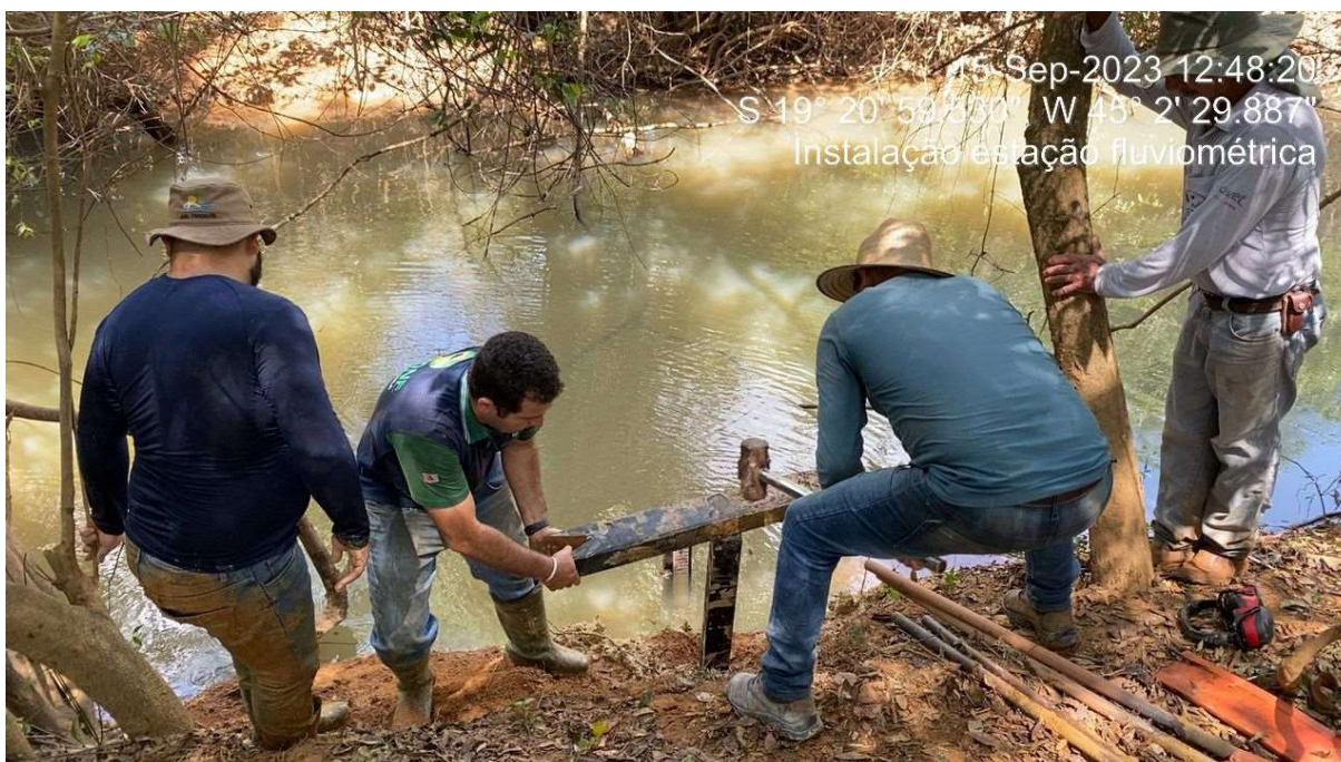
Figura 4.3 – Registro do observador contribuído com a instalação das réguas limnimétricas. Fonte: GAMA ENGENHARIA (2023).
